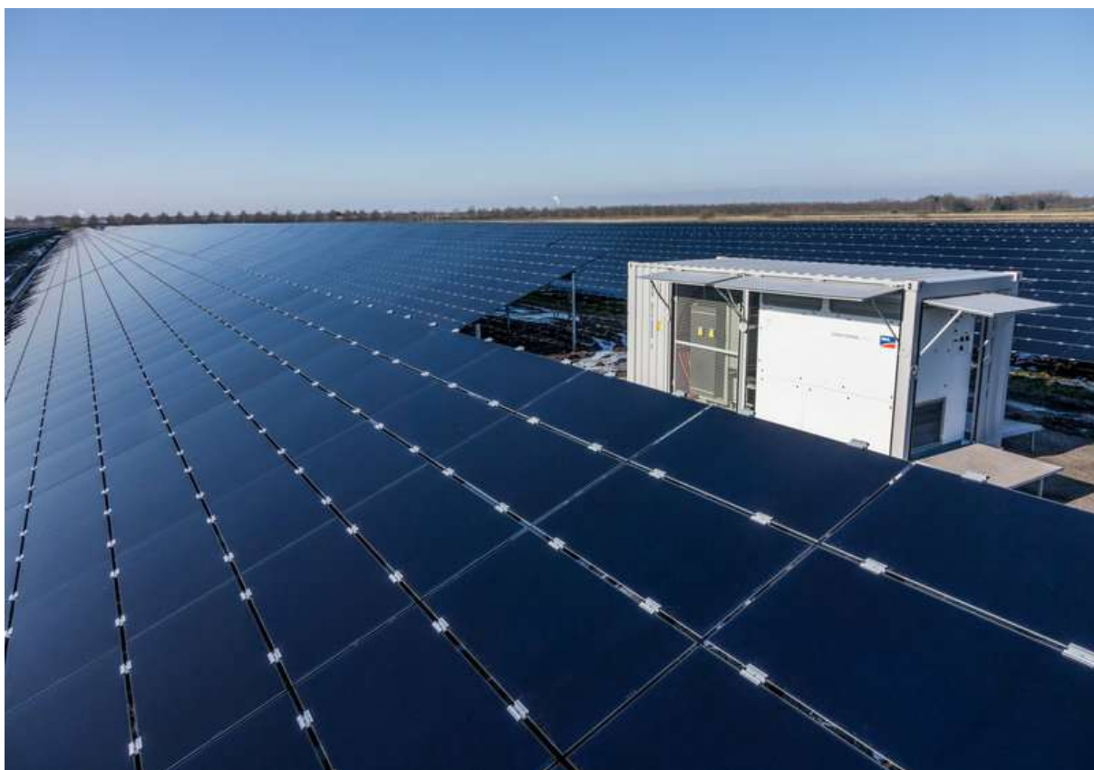
Fot. 4. Kontenerowa stacja rozdzielająca wraz z transformatorem. Zdjęcie www.belectric.com .
