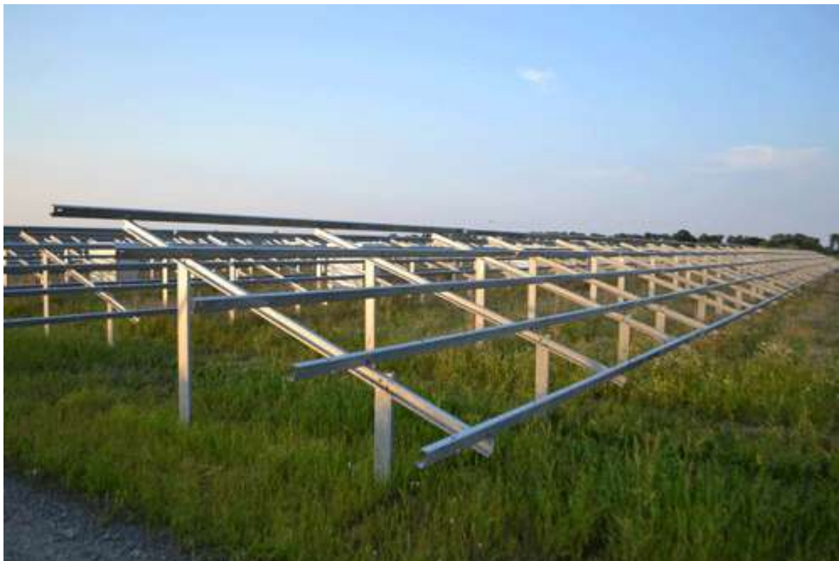
Fot. 2. Stalowa konstrukcja gotowa do montażu paneli fotowoltaicznych. Zdjęcie www.projekt-solartechnik.pl .
